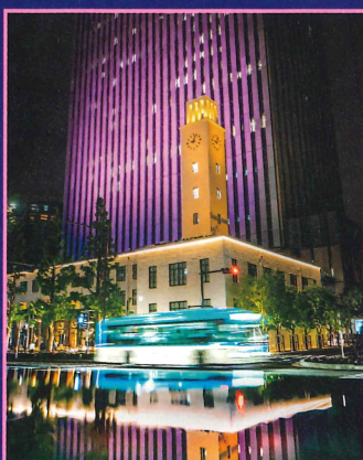
川崎市役所本庁舎
